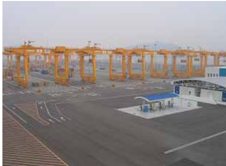
写真：釜山新港のコンテナヤード
