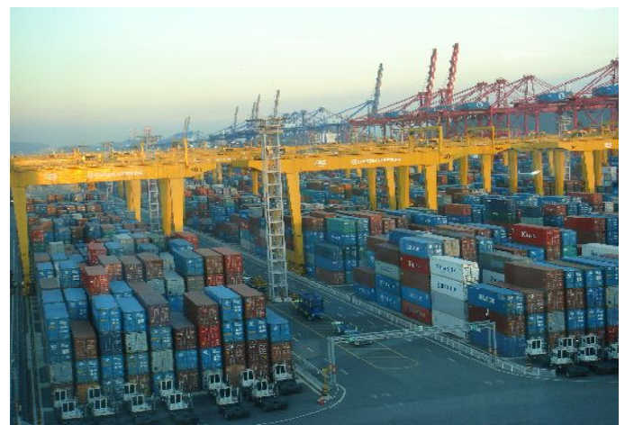
釜山新港・韓進ターミナル
